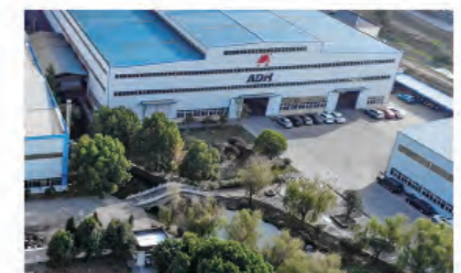
二厂区 ADH Plant 2
