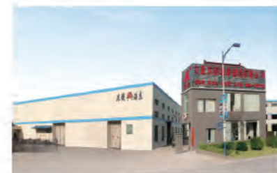
一厂区 ADH Plant 1
